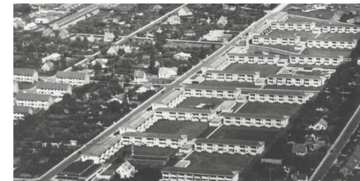
Luftfoto af Strandhavevej-bebyggelsen fra midten af 1950-erne. Denne bebyggelse er opført af præfabrikerede elementer som de, der blev brugt til Papegøjehusene. Neg:A 26,9
